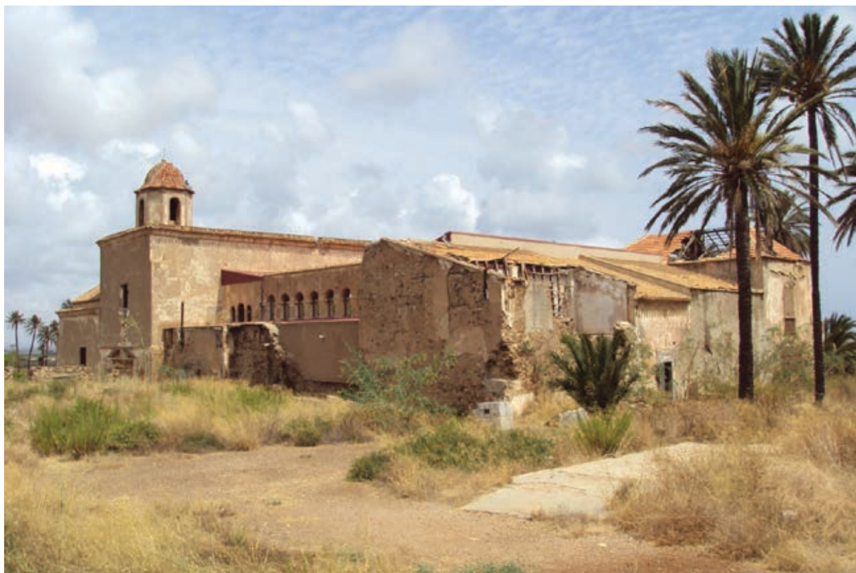
Fig. 6. El Concejo cartagenero facilitó grandes sillares de origen romano a los religiosos de varios conventos como ayuda para poder terminar las obras que habían emprendido en los mismos. Monasterio de San Ginés de la Jara (Cartagena).
