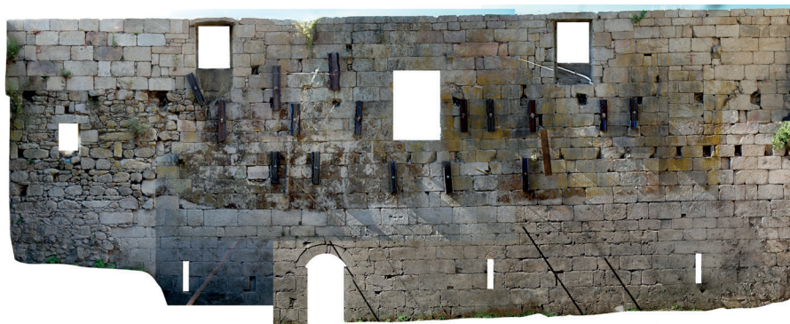
Figura 6: Alçado 1 (Sul) fotografia ortofoto.
