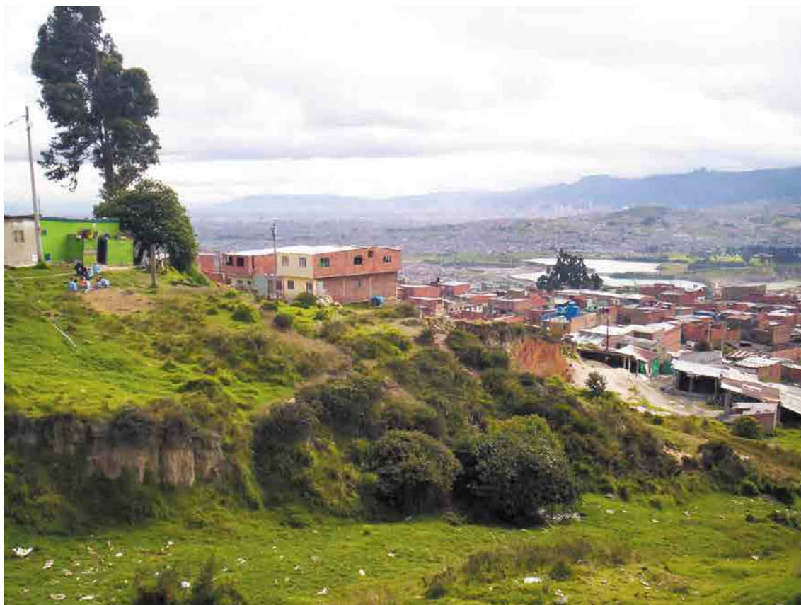
Figura 5 La ausencia de articulación entre el equipamiento y la ciudad. Sector de Ciudad Bolívar – Bogotá. Fuente: Fotografía de Jairo Ovalle (2006).
