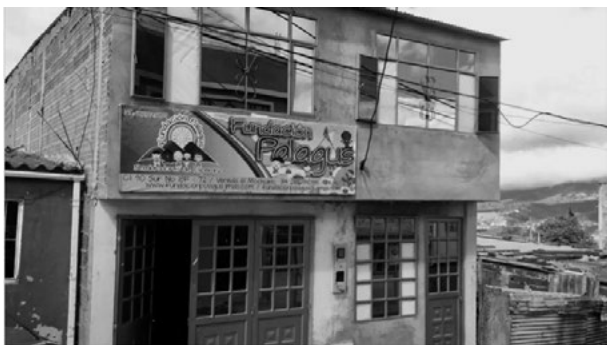
Figura 3. Ubicación de los filtros sobre las ventanas de la Fundación Palagus
