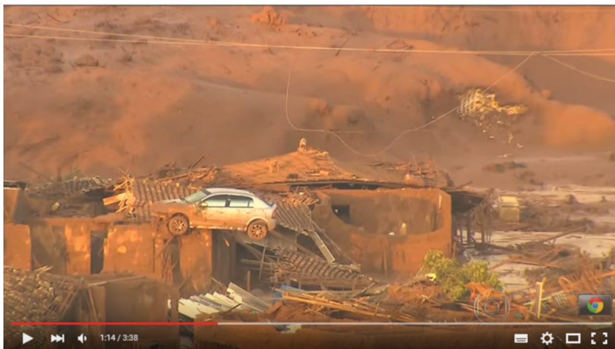
Figura 2 – Imagem da destruição com um carro sobre um telhado
