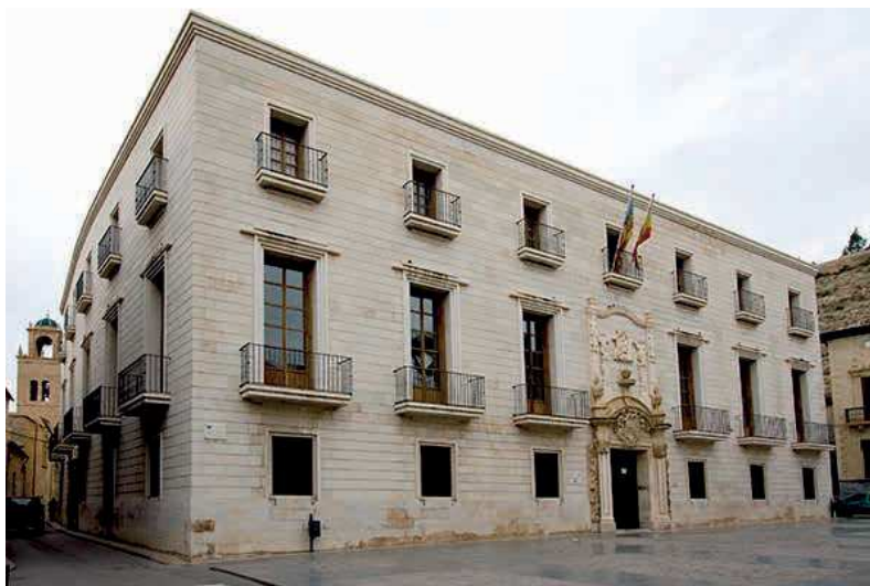
Palacio de los condes de Pinohermoso, padres del marqués de Molins, en Orihuela
