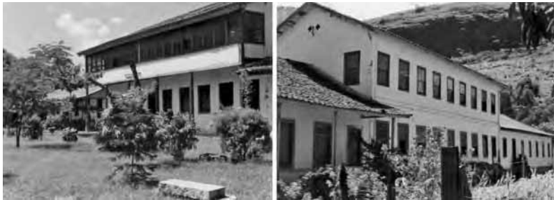
Foto 3 - Casarão da Fazenda do Centro - Década de 80
