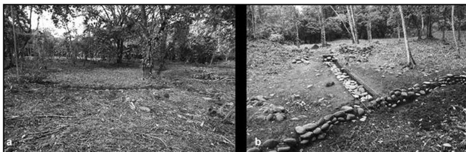
Figura 11. Estanque reflector R30 con (a) su área interna reverdecida por humedad, en la parte media de la imagen izquierda, y (b) el pavimento inclinado, como colector pluvial, junto al muro del estanque, conjunto principal del sitio Las Mercedes. Autor Robert M. Rosengwing.
