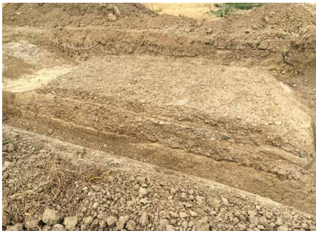
Figura 5. Vista general del tramo de calzada descubierto.
