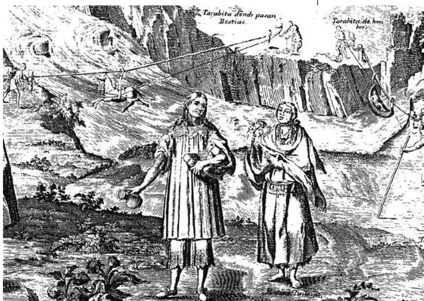
Figura 10. Uso de tarabitas bicable para atravesar un río. Izquierda, un caballo con arnés; derecha, una persona en un cesto (Serrera, 1992, 135, modificada).
