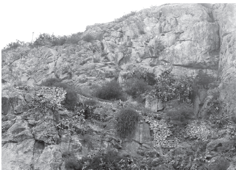
Lám. 3. Detalle de los restos constructivos correspondientes al llamado Camino del Moro (Paco Peña).
