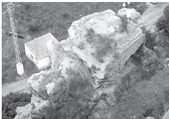
Lám. 2. Vista de la Torre albarrana (Paco Peña).
