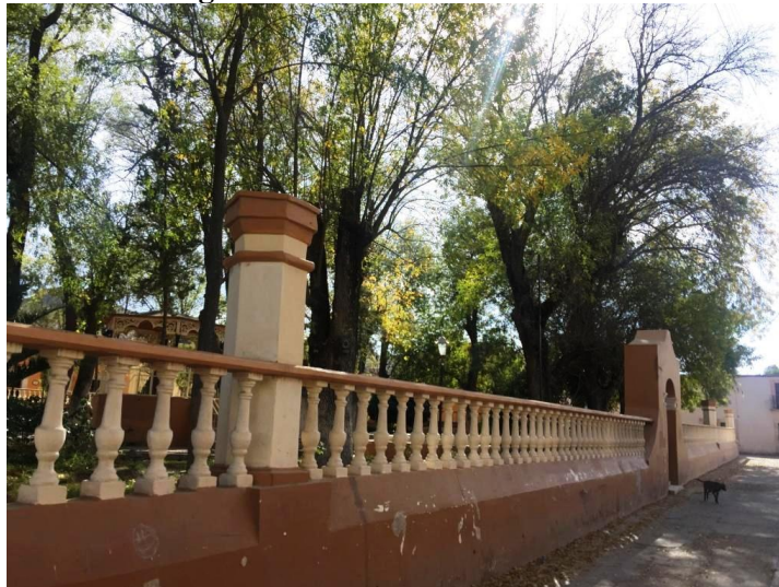
Imagen 8. Balaustrada de La Alameda
