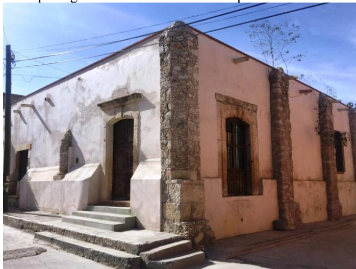
Imagen 9. Finca primigenia característica de la arquitectura de Asientos de Ibarra.
