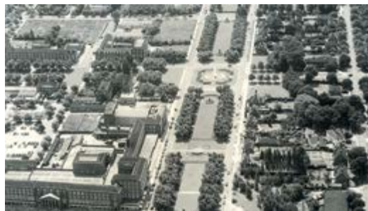
Figura 7 – Vista aérea da segunda cidade-jardim da Inglaterra, fundada em 1920, Welwyn Garden City, no condado de Hertfordshire
