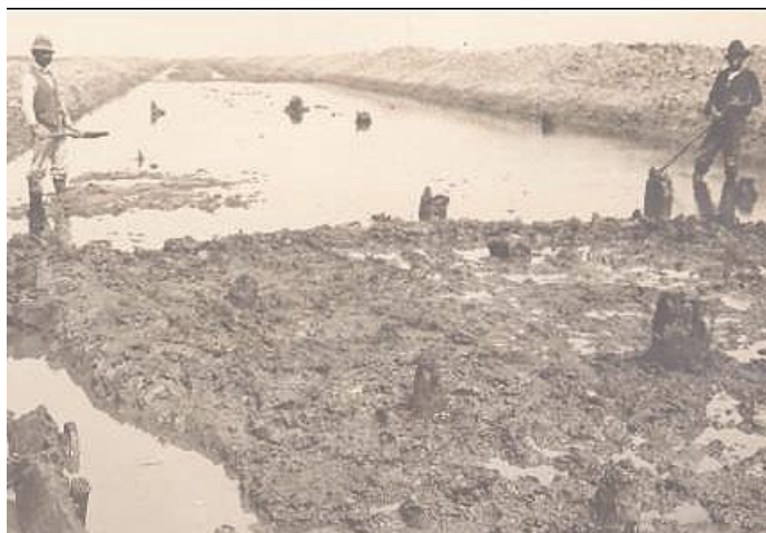
Fig. 7. Comacchio, pilotes hallados en el Valle Ponti por Proni en la década de 1920
