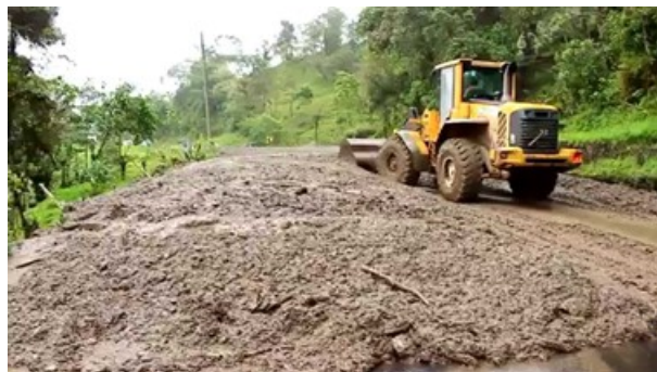
Figura 11. Extendido del terreno. (Yepes, 2015)
