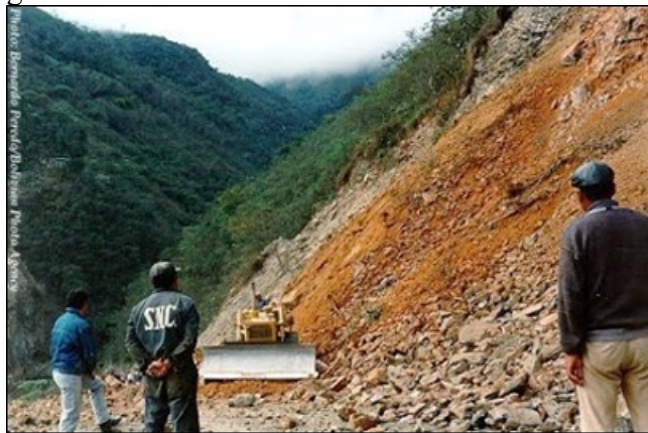
Figura 4. Deslizamiento de tierra en ladera. (Geoenciclopedia)
