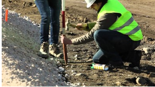
Figura 10. Etapa de replanteo. (Costes, 1975)
