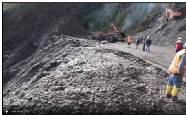
Figura 26. Implementación de la cargadora frontal para limpieza y remoción de tierra en el deslave de la vía Aloag-Santo Domingo. (Gptsachila, 2015)
