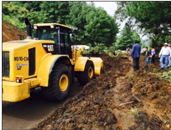
Figura 9. Etapa de despeje previo al movimiento de tierra con a cargadora frontal. (Yepes, 2015)
