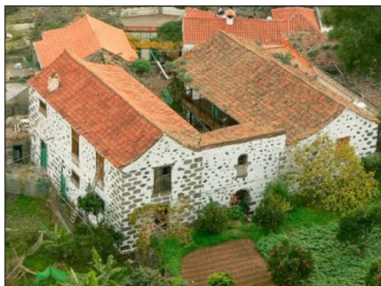
Casa Cuartel de Colmenar
