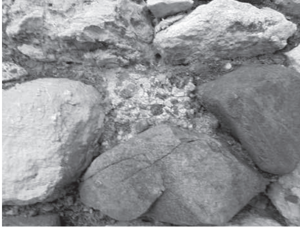
En el reompliment i amb la mateixa mamposteria es va completar el mur amb un tros de paviment romà d' opus signinum .
