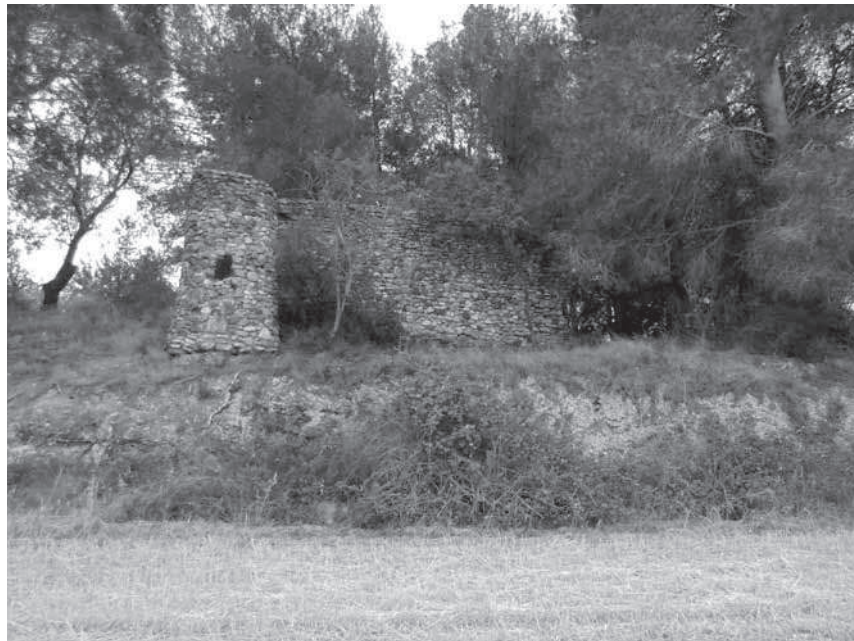
Mur amb l'absis del costat exterior; està assentat a sobre d'un talús molt sòlid.
