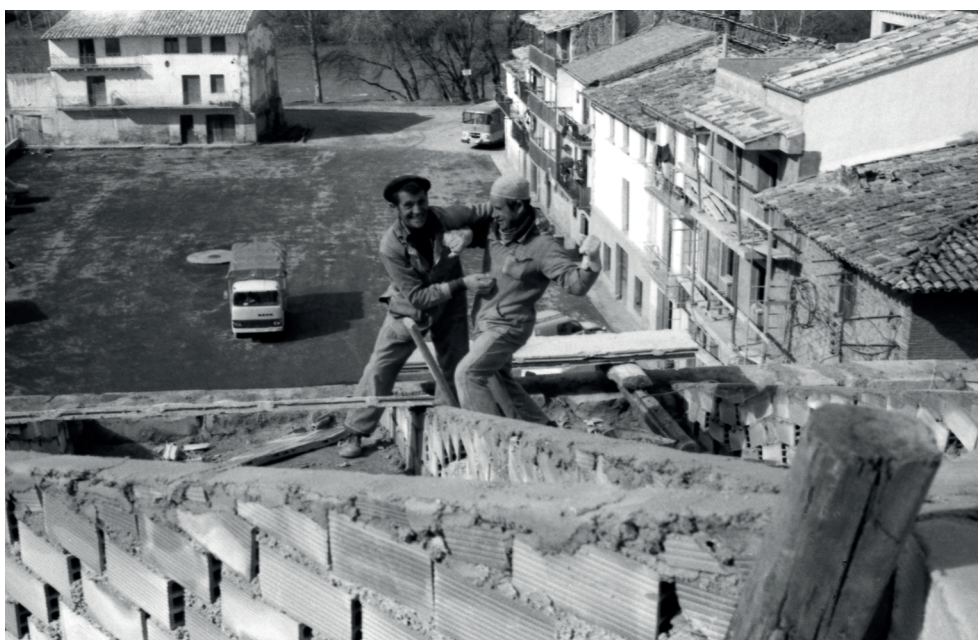
Arreglando el tejado de San Salvador.
