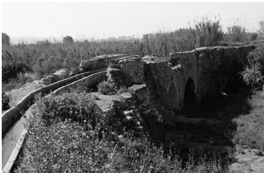
Vista actual del Pont de les Caixes.
