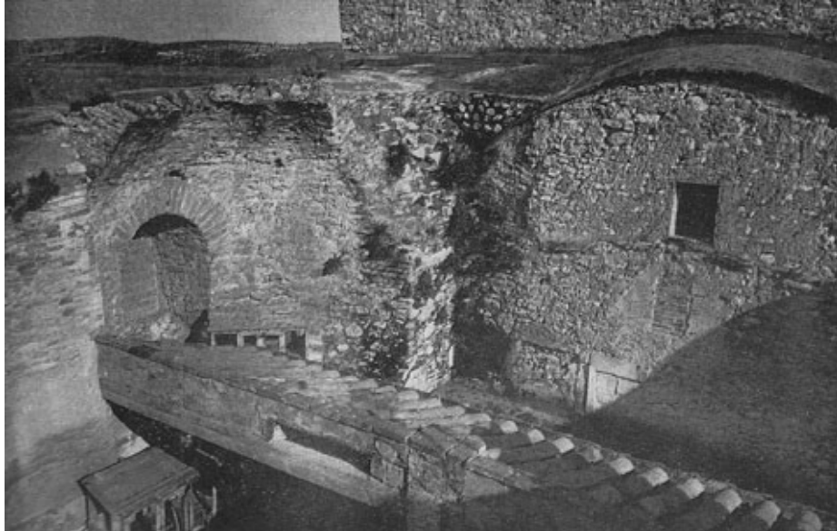
Interior de la sala quadrilobulada. Estat abans de 1959.
