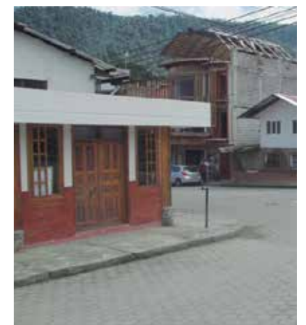
Fotografía 8. Construcciones en Mindo Zhunio, Bladimir. 2014
