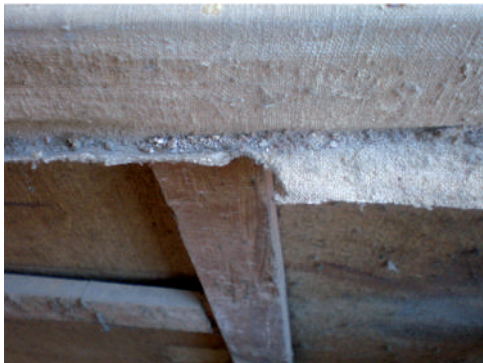
Suciedad acumulada en el soporte y estado del bastidor.
