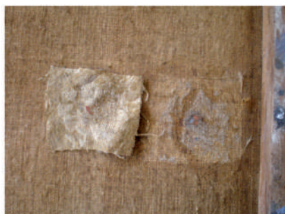
Eliminación de tres parches.
