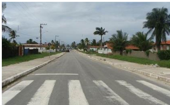
Figura 1 - Asfaltamento e construção de calçada ao longo da via principal de Itapuama
