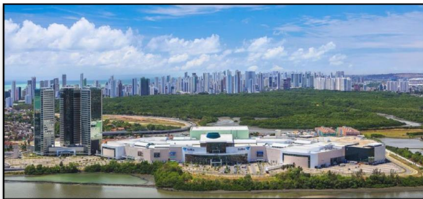
Figura 03 – Foto em perspectiva da área onde se encontra o Shopping Riomar, na qual é possível observar as três torres Riomar Trade Center.
