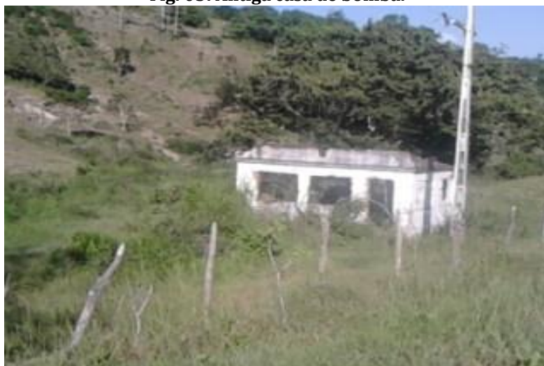
Fig. 03: Antiga casa de bomba.
