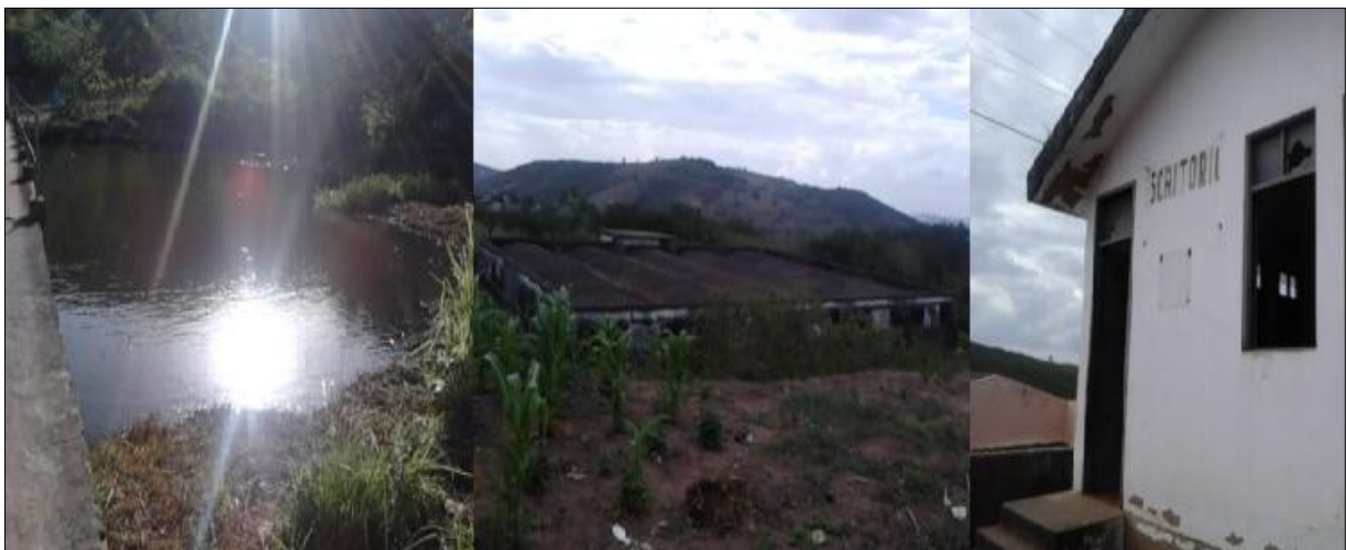
Fig. 04: Imagem da represa, do reservatório e do escritório da CAGEPA no município de Umbuzeiro, PB.
