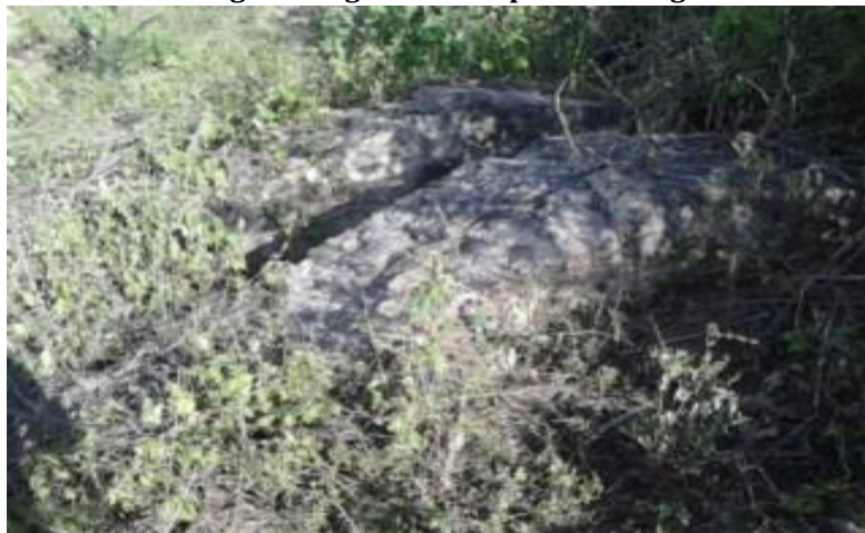
Fig. 02: Ruínas da antiga barragem da Companhia de Águas em Umbuzeiro.
