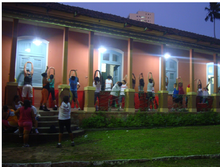
Figura 03: PAC – Unidade Sítio da Trindade – Casa Forte Fonte: Dannilo Lima, junho/2012
