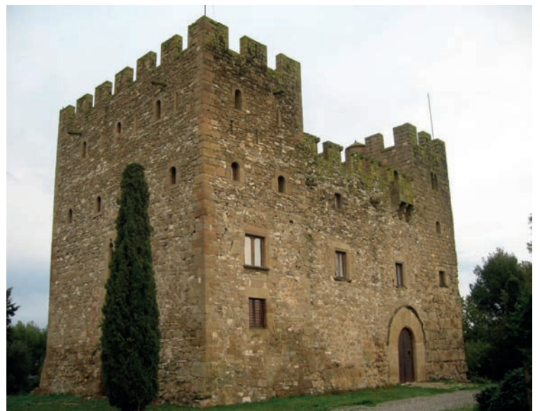
Figura 5. Castillo de la Ràpita después de la remodelación arquitectónica y estructural.
