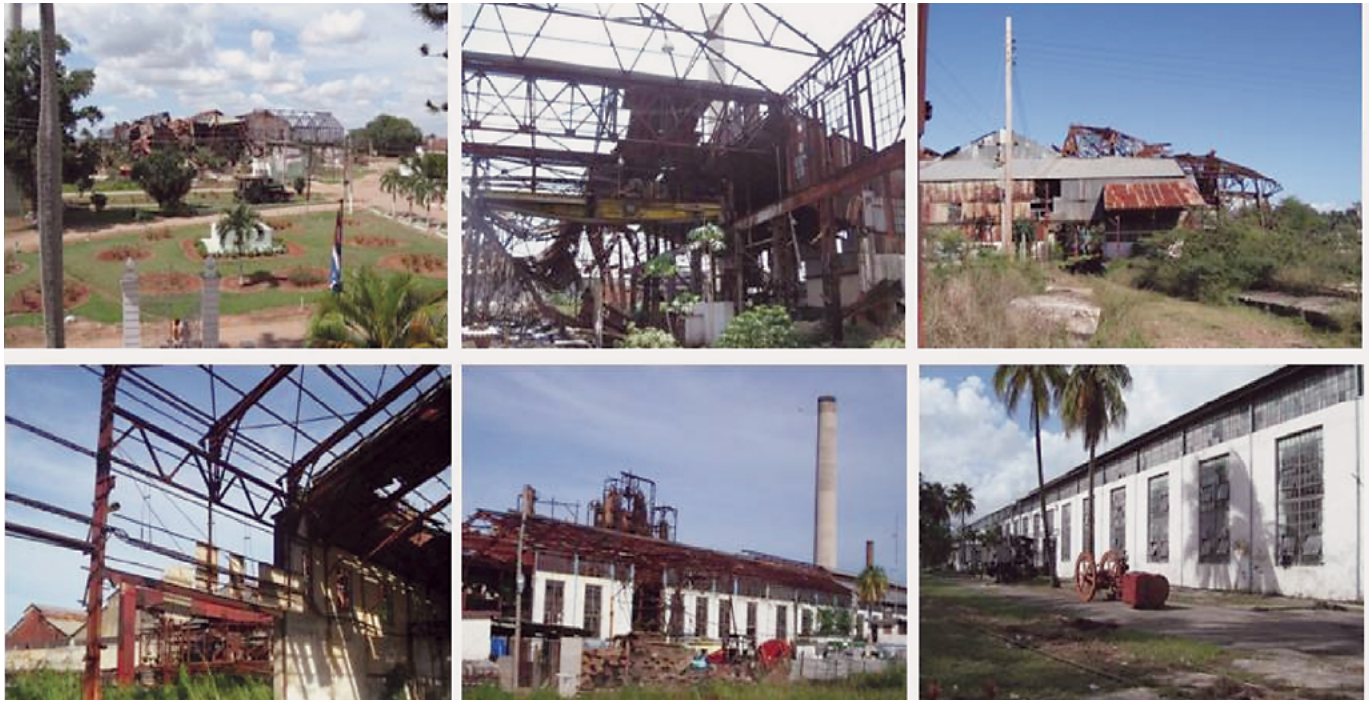
FIGURA 1. Aspecto del deterioro de instalaciones industriales desactivadas de los centrales Amistad, Hershey y Toledo (Fotografía: Adrian González González, Indira Costa Fallarero y Tania Gutiérrez Rodríguez, 2008; cortesía: grupo empresarial Azcuba).
