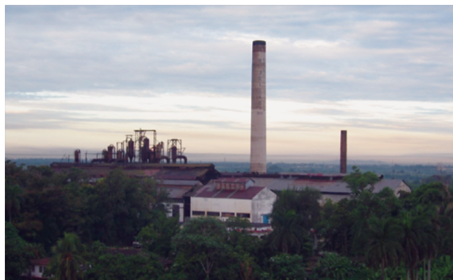
FIGURA 4. Central Toledo, aspecto de la industria antes del proceso de desmantelamiento (Fotografía: Adrian González González, Indira Costa Fallarero y Tania Gutiérrez Rodríguez, 2009; cortesía: grupo empresarial Azcuba).
