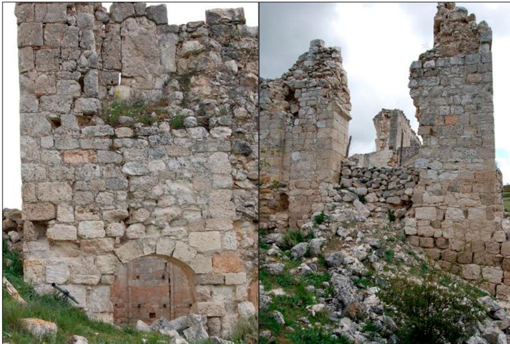
Figura 40.- Accesos a la iglesia desde el muro a los pies del templo. A la izda, la pequeña puerta superior para el coro y la inferior para la iglesia. Bajo la puerta alta se observan los mechinales de un forjado de madera que constituía el piso de acceso. A la dcha, jamba y arranque del arco de la puerta de acceso a la nave lateral del templo y al coro.
