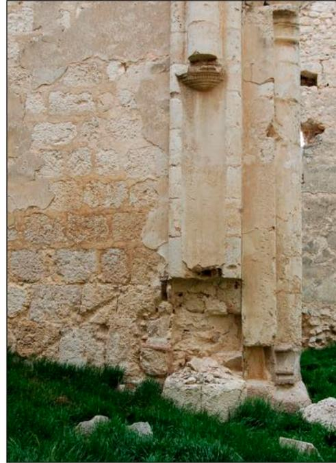
Figura 39.- Arrangue de la pilastra de la nave de la epístola con las improntas del púlpito: la escalera fijada a la pared, la peña arrancada y el tornavoz, también desaparecido, en la ranura superior.
