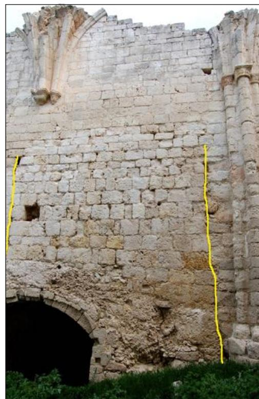
Figura 1.- Paramento norte de la iglesia donde aparece integrado un muro de construcción anterior sobre la gruta de Los Valles, posible construcción original del convento.
