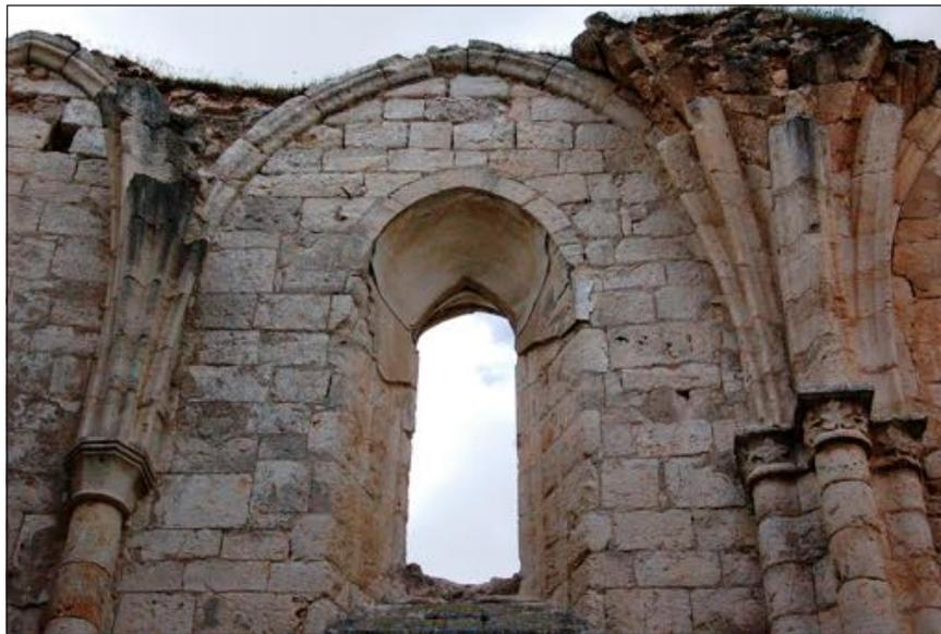
Figura 35.- Remate del cierre de la nave, con el arranque de los nervios y los capiteles de hojas de vid a la derecha. El ventanal, luego retallado y cubierto con yeserías barrocas, es la única apertura para la iluminación de la nave a mediodía.
