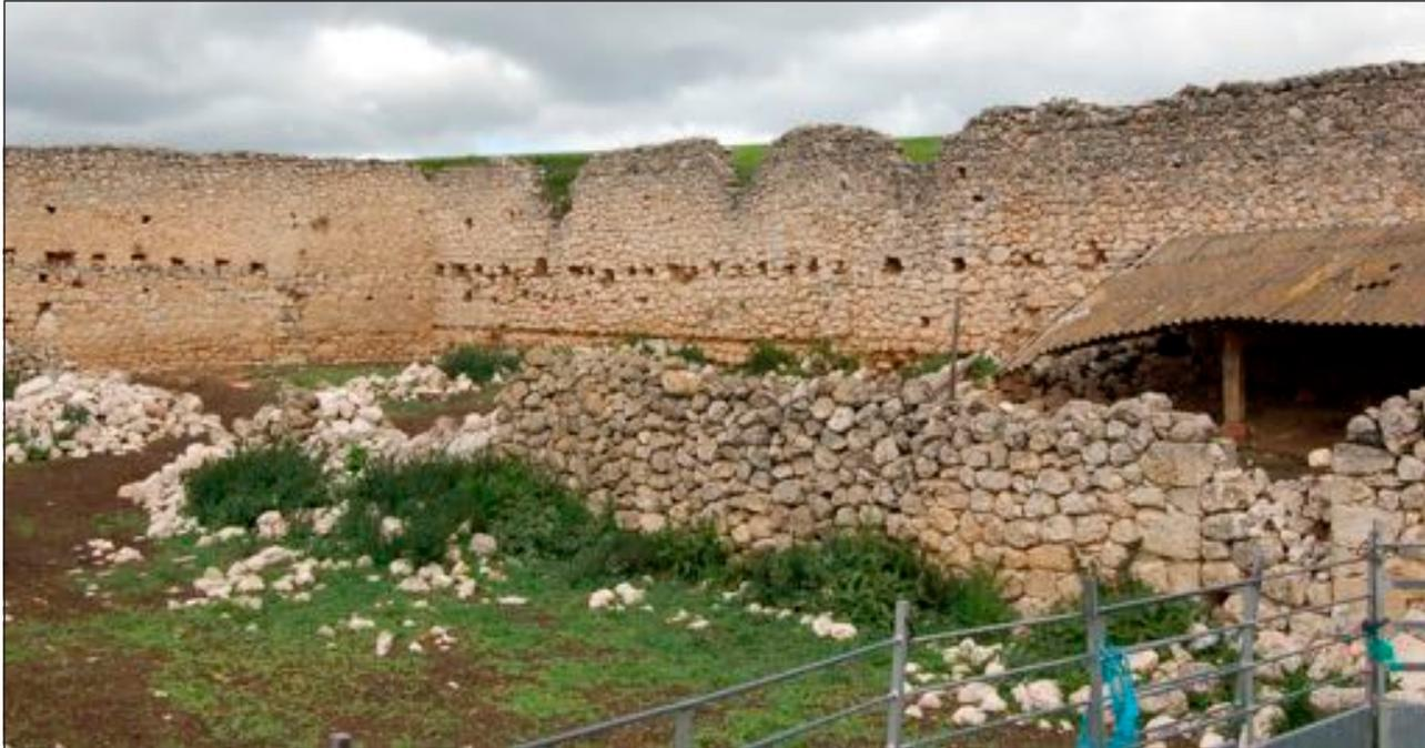
Figura 42.- Muro perimetral exterior de la parte alta del convento, con los mechinales para las vigas del forjado de un piso.
