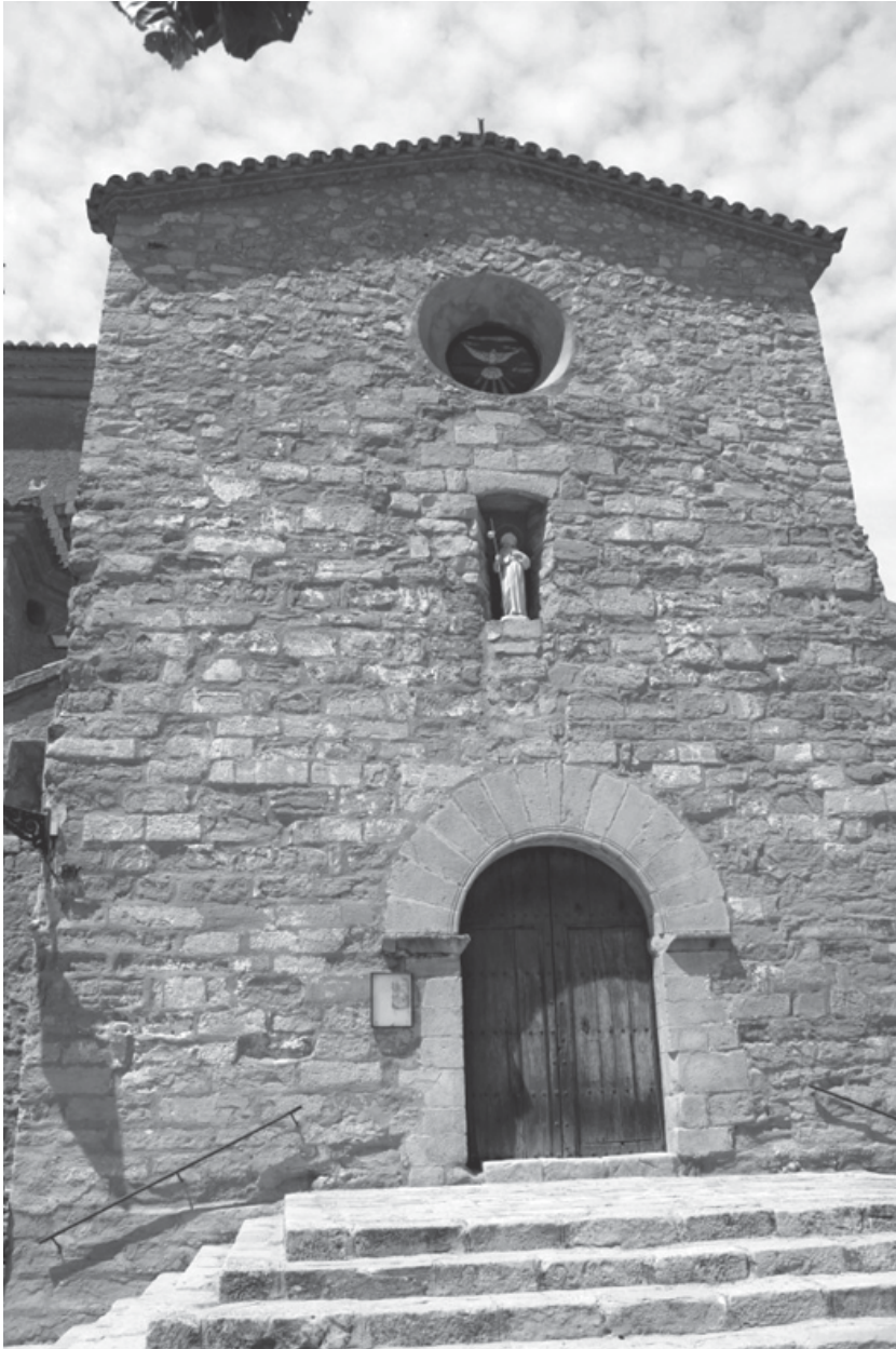
Façana de 1350 que substituï l'antic absis romànic, recrescuda durant el segle XVII (Foto autor).
