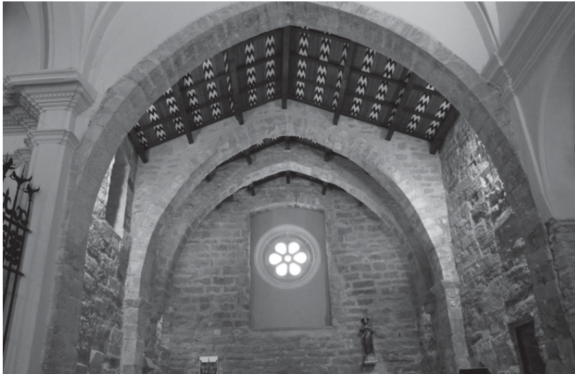
Arcs diafragmàtics propers a la porta romànica. El teginat actual es decorà copiant el de l'església de Sant Miquel de Montblanc (Foto autor).
