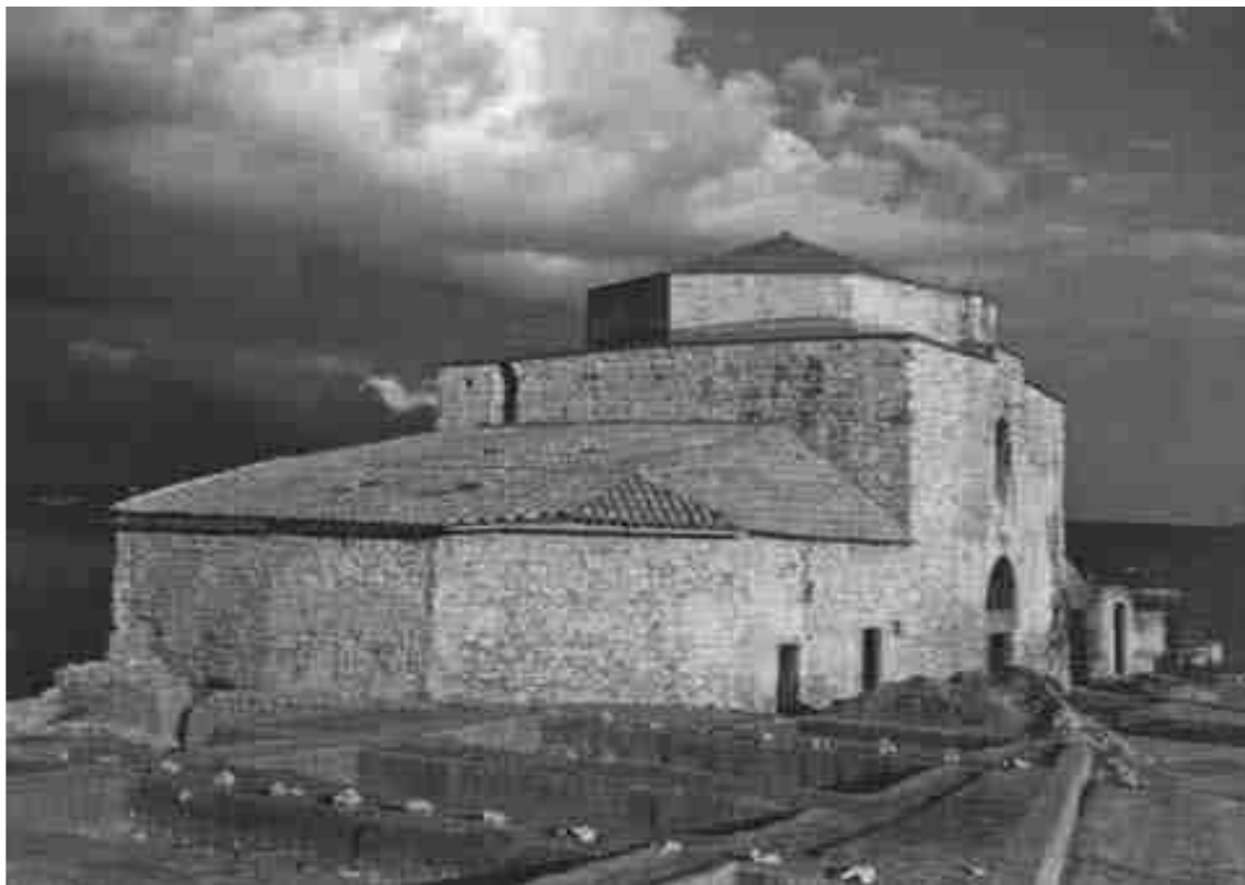
Vista dels edificis conservats a la vil·la romana de Centcelles (s. IV).
