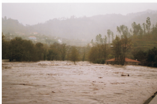
Fot. 1 - Inundação em 2001, na Praia da Valeta em Arcos de Valdevez. Ao fundo está localizado a Azenha Bar com a água até à cobertura (telhado) (R. AGUIAM, 2008)
