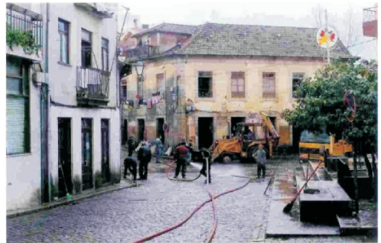
Fot. 3 - Limpeza dos arruamentos e edifícios da AD Valeta após a inundação de 1999. Pode-se observar os edifícios danificados nas fachadas, portas e, como se depreende, no seu interior (R. AGUIAM, 2008)
