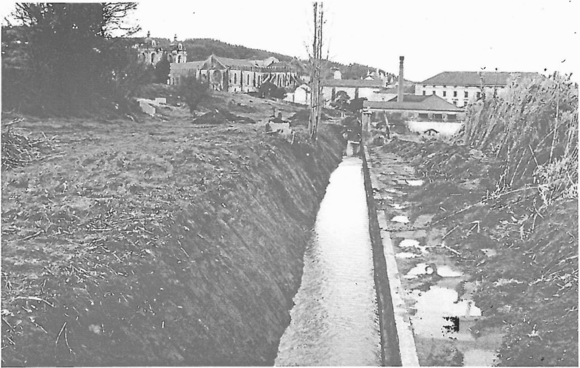
Foto 35 - A Levada a "caminho" do Mosteiro, na direcção da Sacristia, com a "Livreria" à direita. Nota-se o depósito das terras de limpeza (P.TAVARES, 1999).
