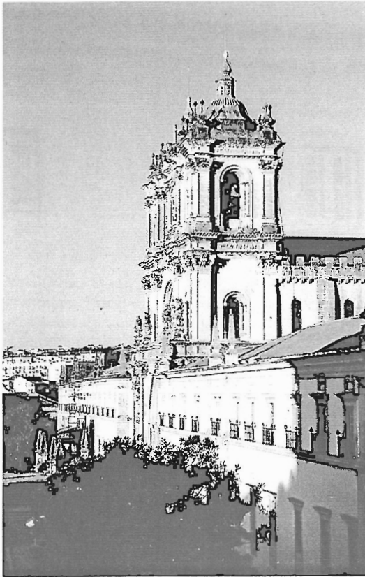
Foto 43 - O longo Alçado Principal Poente, em foto razante, notando-se no friso e cimalha em pedra ao fundo, no topo Norte da Ala Norte (Palácio Abacial), o afundamento construtivo na aproximação ao Rio Baça e que atinge 42 cm (P.TAVARES, 1999).
