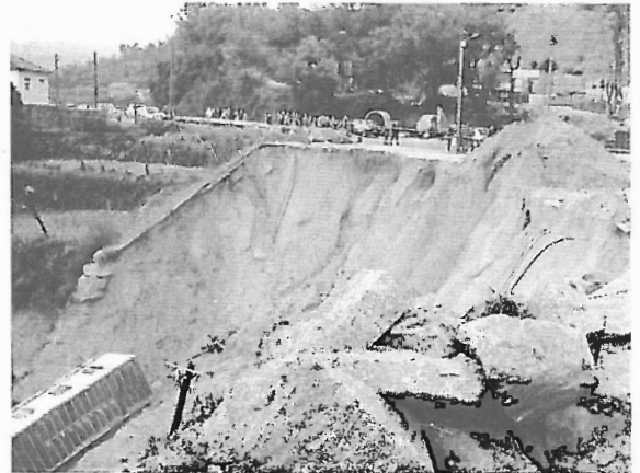
Foto 11 - Cicatriz do movimento de Ventosa (Vieira do Minho). A cicatriz desenvolve-se totalmente nos materiais do aterro.
