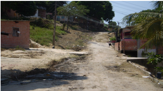
Fotografia 7 - Exemplo de ruas sem manutenção em seu pavimento. Fonte: RIBEIRO A.A.A., (2008).
