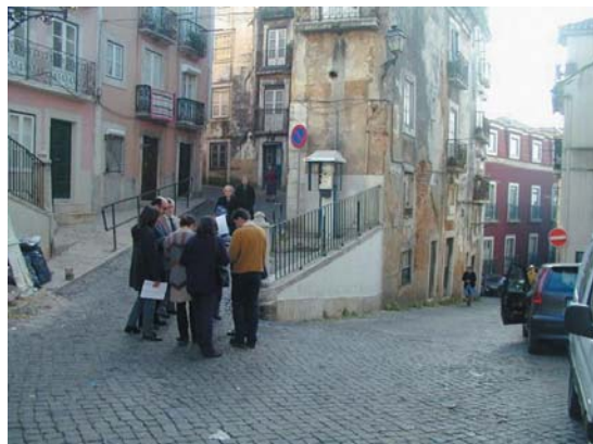
Foto 4 - Prédios em diferentes graus de conservação. Fotografia de Manuel João Ribeiro
