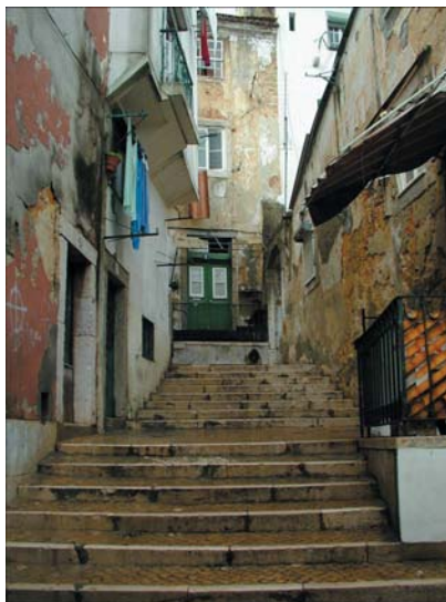
Foto 3 - Rua em escadaria. Fotografia de Manuel João Ribeiro
