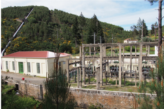
Fot. 15 - Vista geral da Central hidroelétrica do Esteiro (fotografia de Luciano Lourenço).
