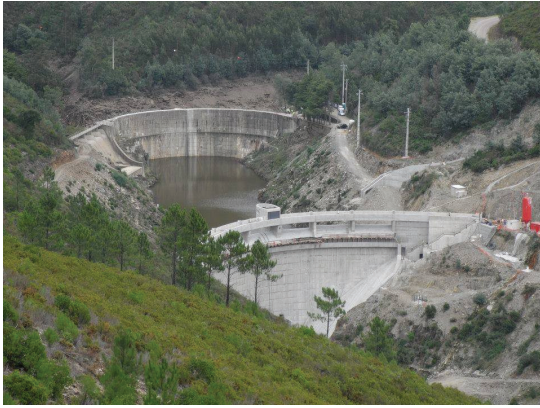
Fot. 3 - Enquadramento das barragens na fase de construção (Fonte: http://www.cambaonline.com/index.php/info-online/noticias-da-aldeia/108-nova-barragem-do-alto-ceira ).
