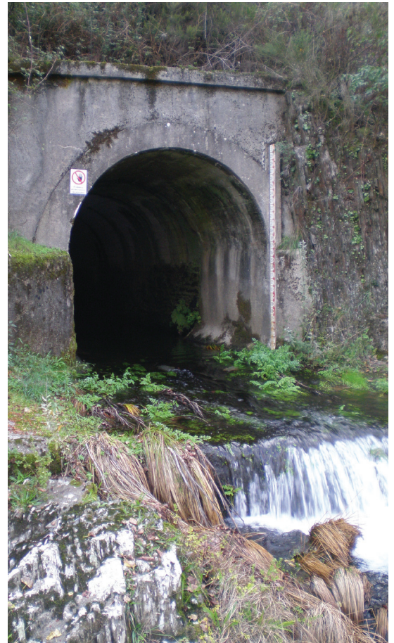
Fot. 6 - Detalhe da saída do túnel do Tojo, afluente à albufeira do Alto Ceira (fotografia de Carlos Cruz).
