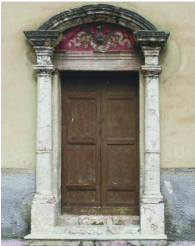
Fig. 3. Mezzojuso. Chiesa di Santa Maria di tutte la Grazie, portale laterale.
