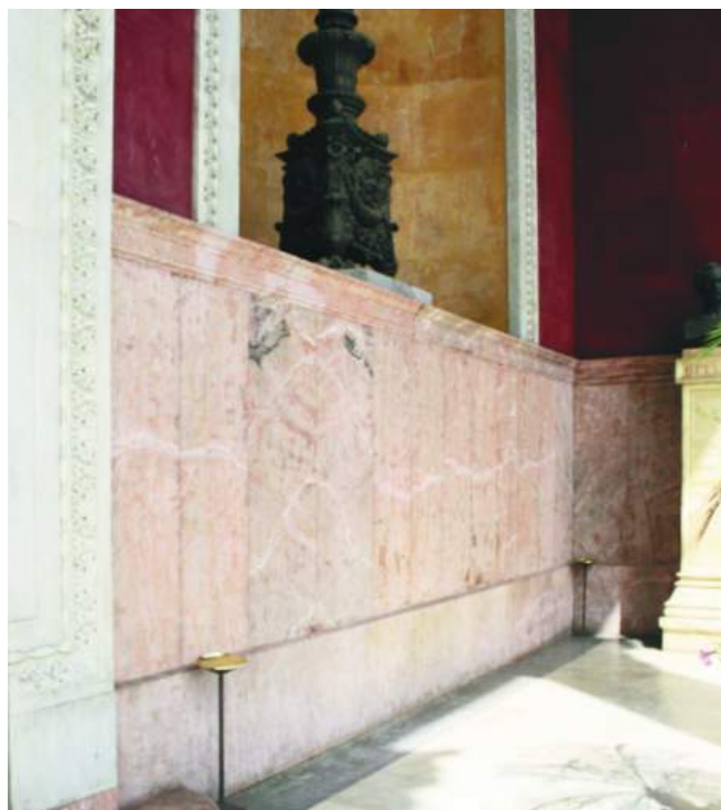
Fig. 20. Palermo. Teatro Massimo, particolare della fascia basamentale esterna.
