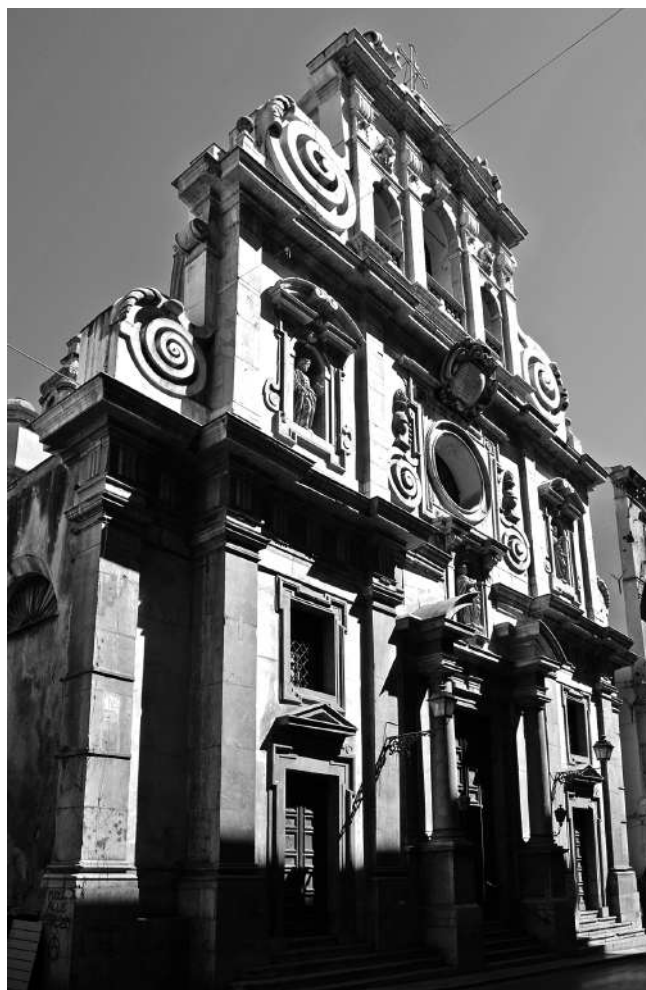
Fig. 3. Palermo. Chiesa di San Matteo, facciata.
