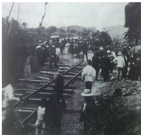
Imagen 7. Construcción de línea férrea.
