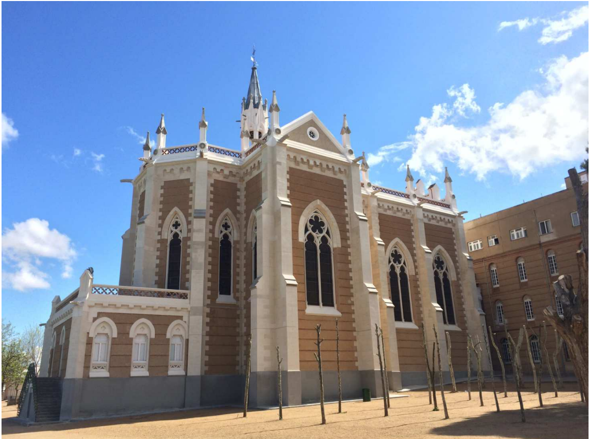
Fachada lateral de capilla
