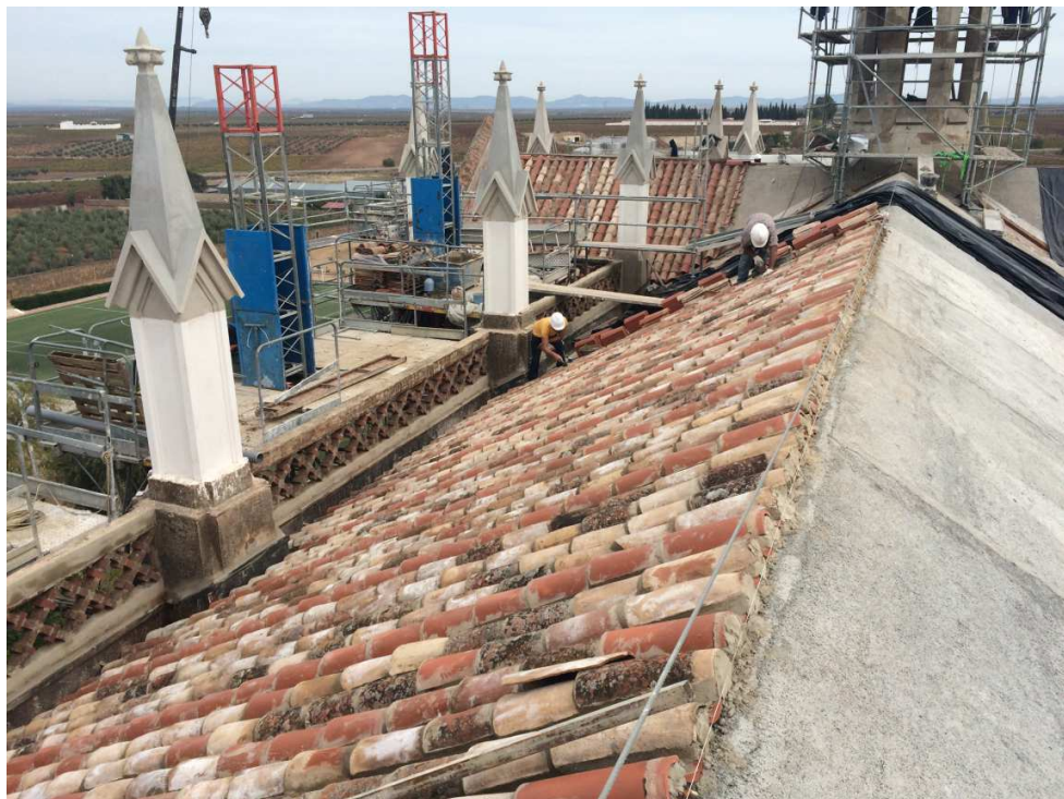
Imagen general de los pináculos restaurados.
