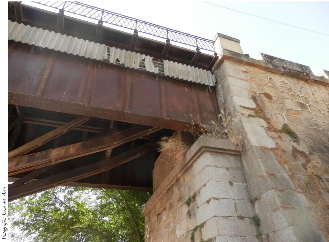
Estribo derecho (detalle)
