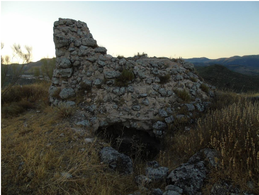
Torre de la Fortaleza del Cerro del Algarrobo.
