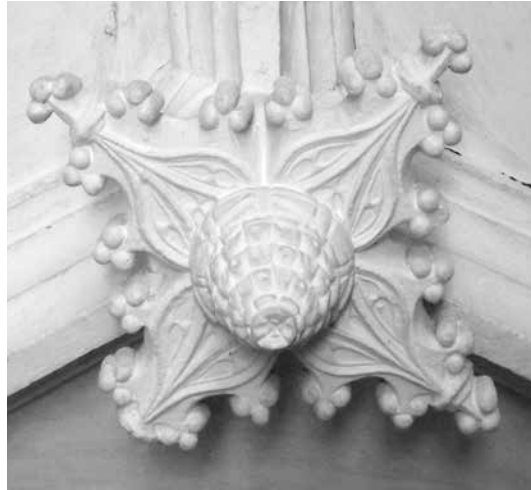
Fig. 16.- Clau de volta de l'església de Montlleó (foto: J.Y.).
