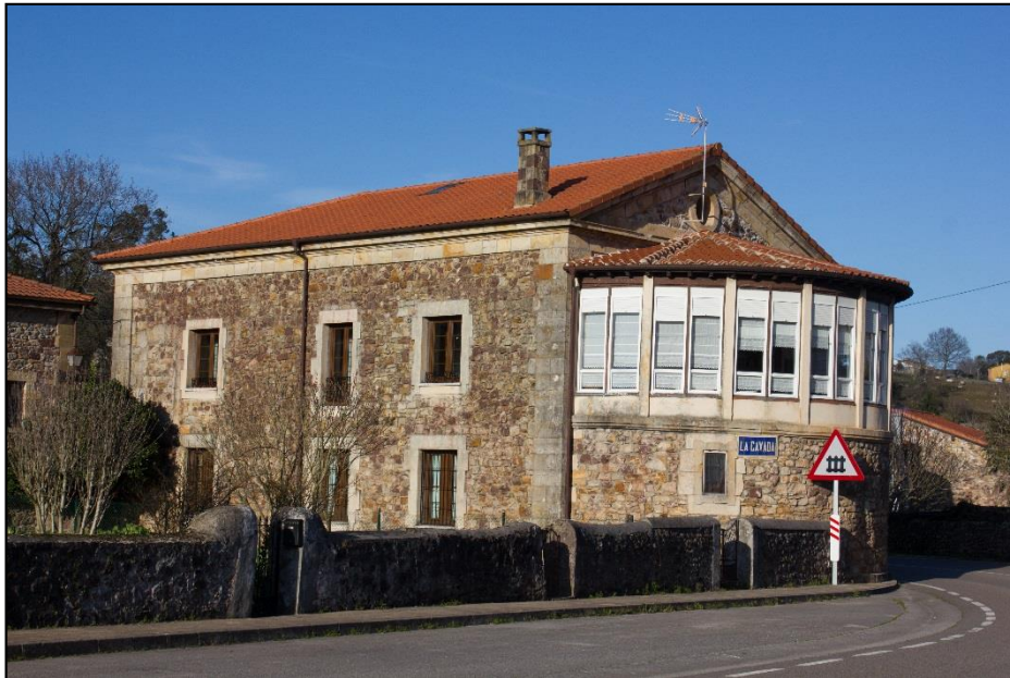
Figura 11. Capilla de Santa Bárbara, hoy transformada en vivienda.
