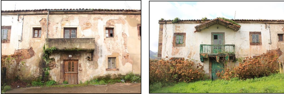
Figura 12. Viviendas de operarios en la manzana este.
