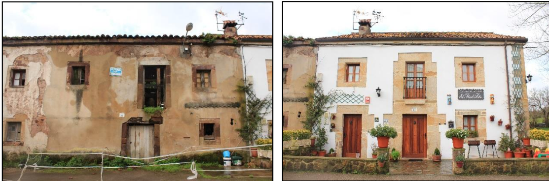
Figura 13. Viviendas de operarios en la manzana este.
