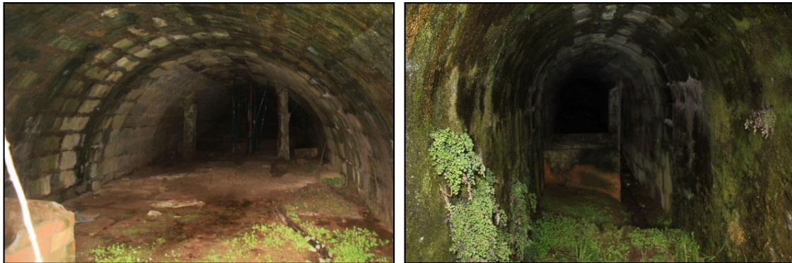
Figuras 6 y 7. Imágenes del túnel del canal y el túnel de los talleres.
