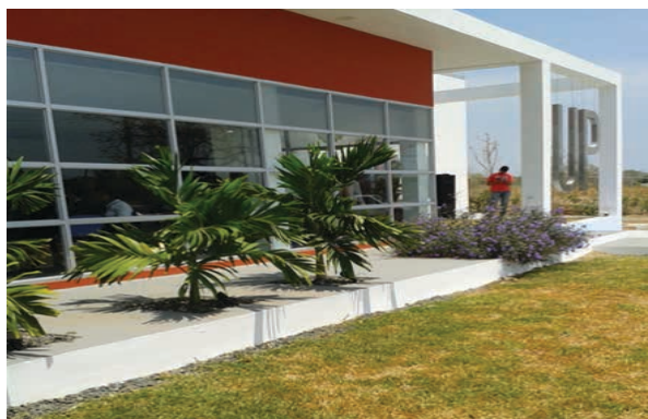
Figura 1. Fachada del CIDETE de Panamá Oeste. Fuente: Elaboración propia
