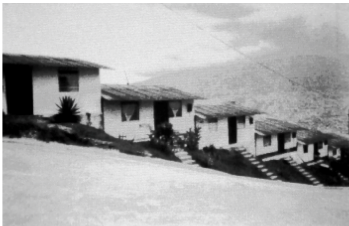
Imagen 1. Solución de vivienda mínima. Manizales - Colombia. Fuente: Sánchez, 2000.
