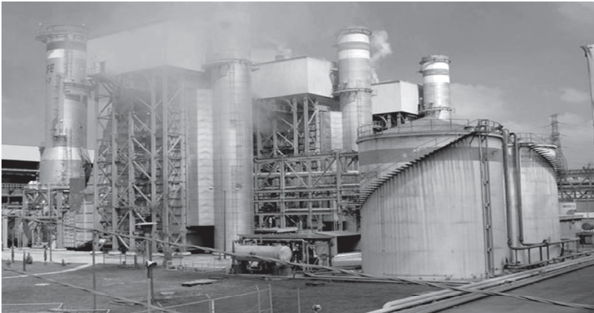
Fotografía 1. Planta de generación termoeléctrica de ciclo combinado Fuente: El Economista, 29/09/14, pp. 28-29.
