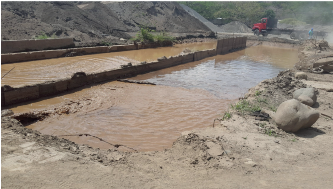
Figura 3. Fotografía del sedimentador en el 2015.
