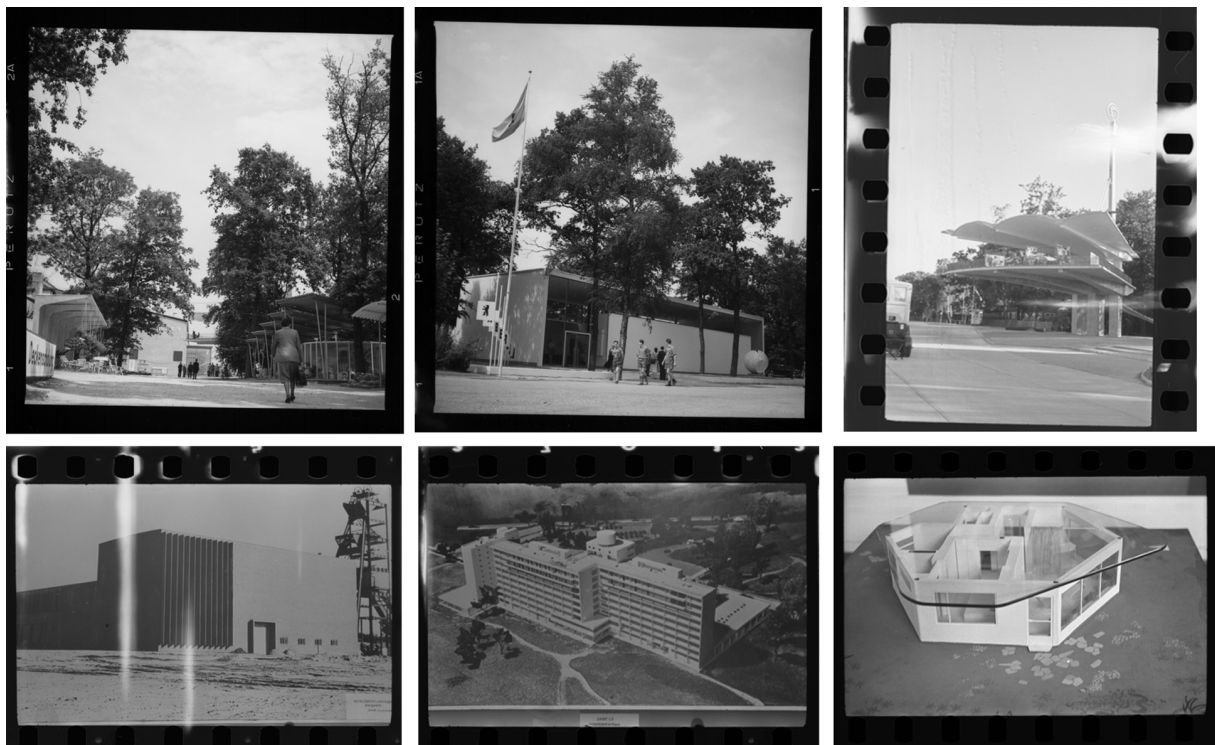
(Fig. 6) Conjunto de imágenes de la exposición "Constructa Bauausstellung", de Ramón Vázquez Molezún Servicio Histórico del COAM, signatura VM/F0166
